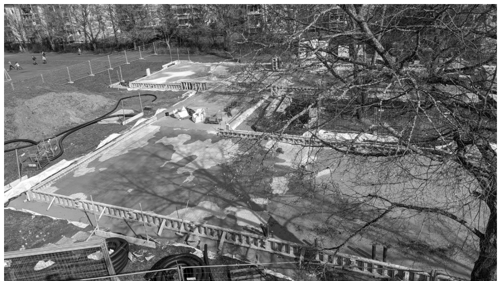
Arbeiten an der Bodenplatte im März 2023
