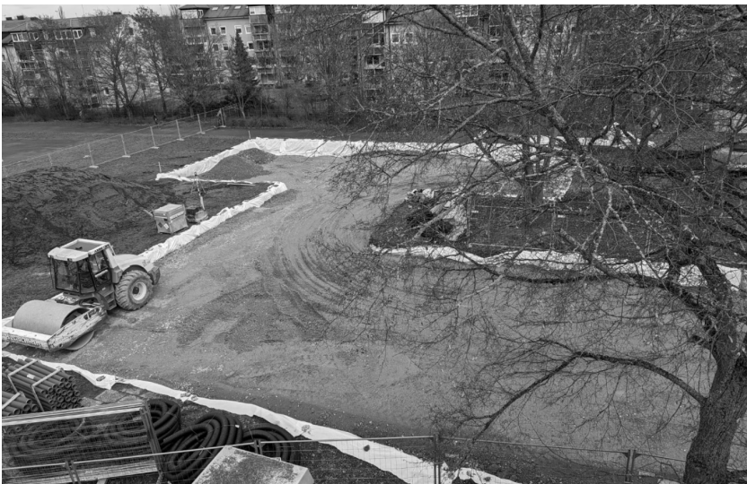
Arbeiten am Fundament im Februar 2023
